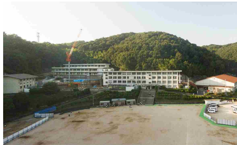
▲工事が進む井原中学校 (写真提供: 石井写真館)
